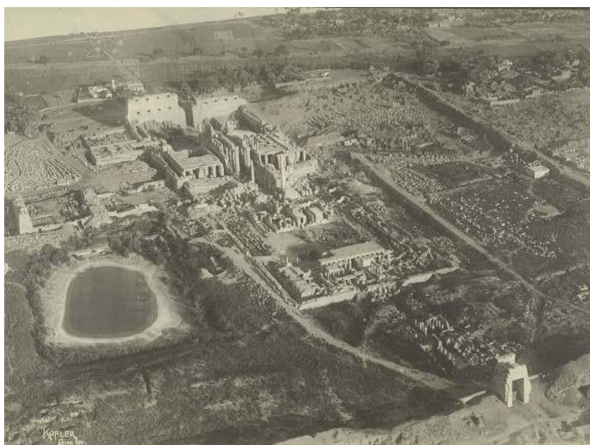
Foto aérea das construções do templo de Karnak
